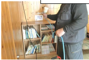
ハイブリッド光触媒GLコート施工の様子
