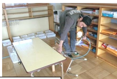
ハイブリッド光触媒GLコート施工の様子
