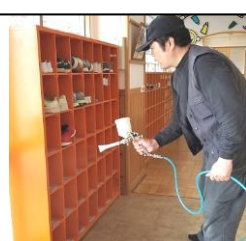
ハイブリッド光触媒GLコート施工の様子
