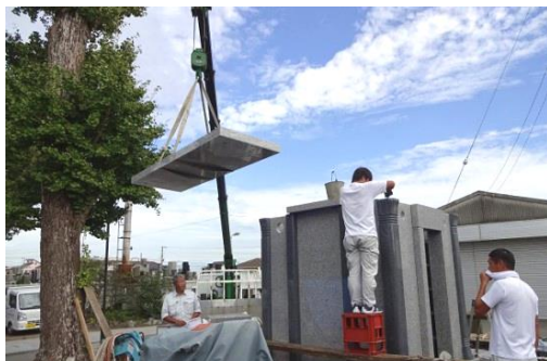
納骨堂工事の様子 平成27年10月
